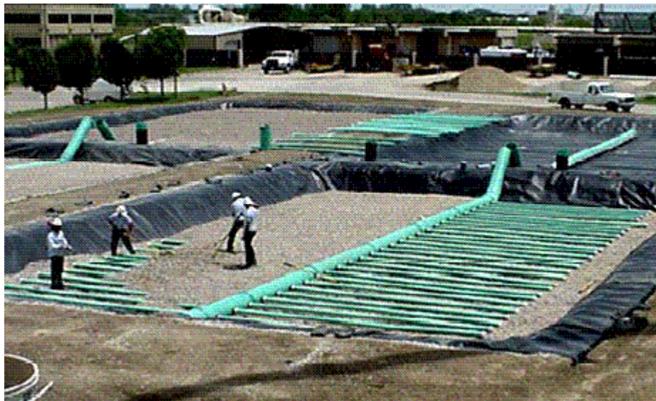
Figura 5. Fotografía de cuatro biofiltros que se están instalando en Arlington, TX en la planta del sistema efluentes de central regional
