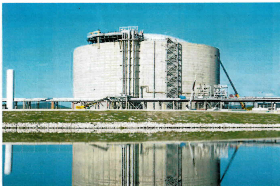
Tanque de almacenaje de gas natural licuado con capacidad para 42 MM 7 de galones.
